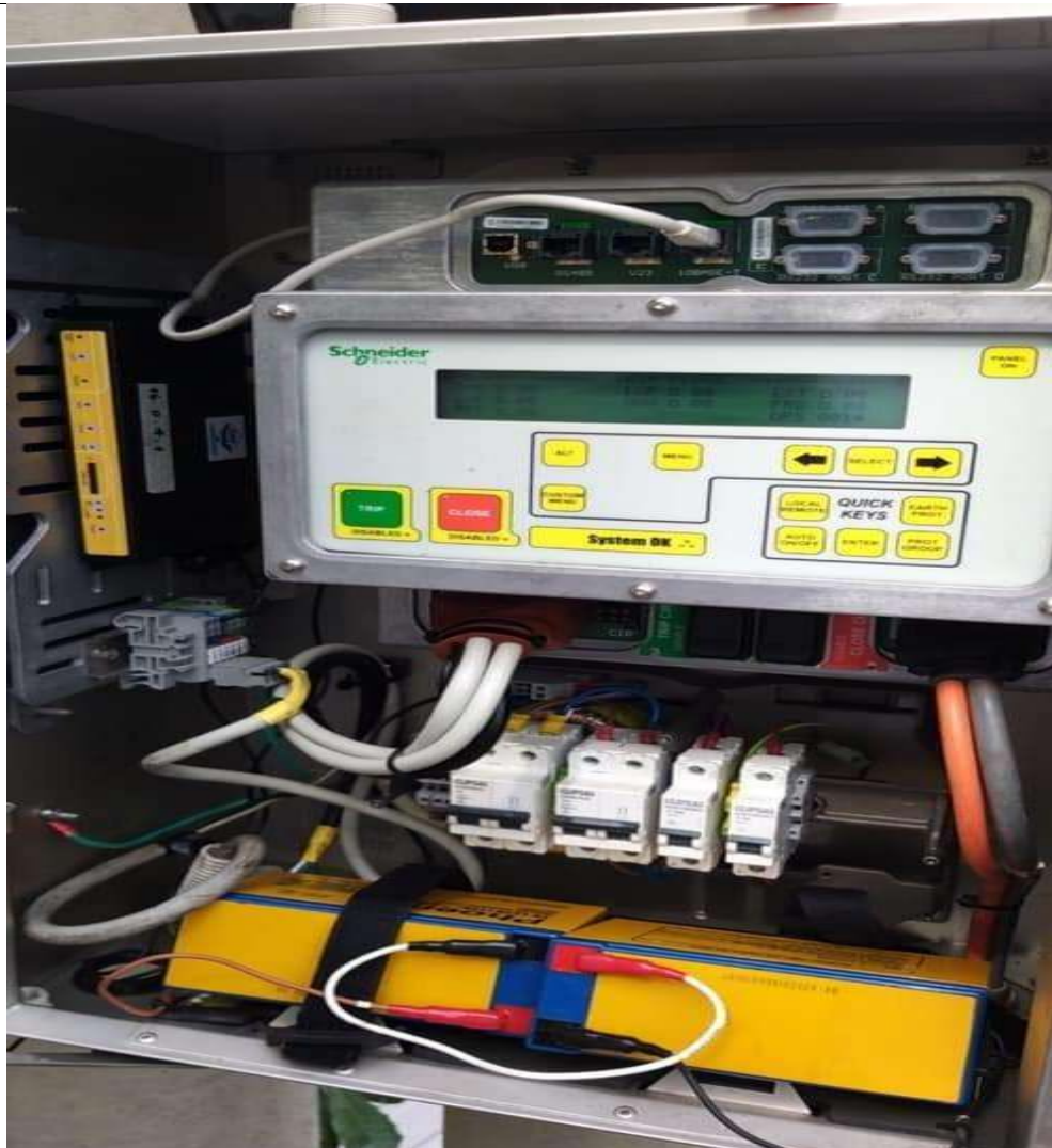
Lắp đặt, kết nối Modem F3425 với máy cắt
